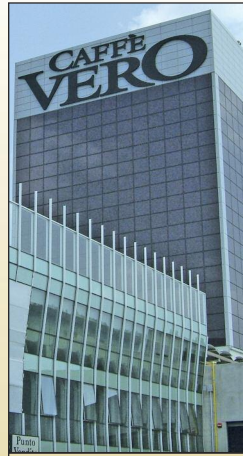
Silo esterno per caffè verde o tostato External silos for raw and roasted coffee
